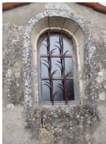
Fig.33 - Décrochage de clef de voûte (église Notre Dame de Salles).
