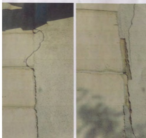
Fig. 11 – Endommagement déclaré après le séisme.
