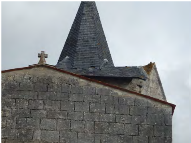
Fig. 32 – Glissement d'Ardoises (église Notre Dame de Salles).
