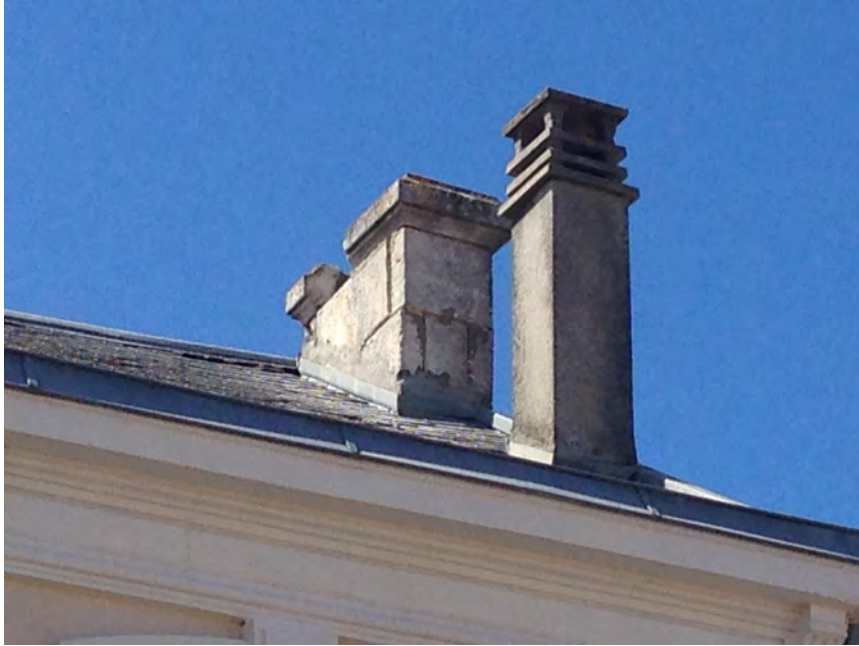
Fig. 15 - Partie de cheminée endommagée rue du marché.
