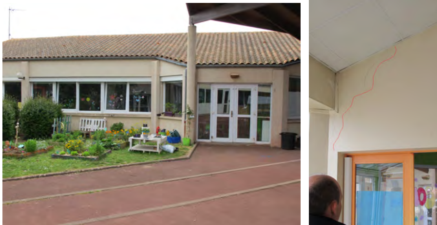
Fig. 26 – Dommages de degré 1 - école maternelle d'Angoulins.
