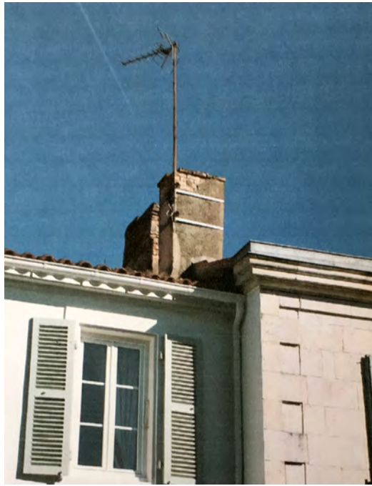
Fig. 42 – Fragilisation des cheminées (2016).
