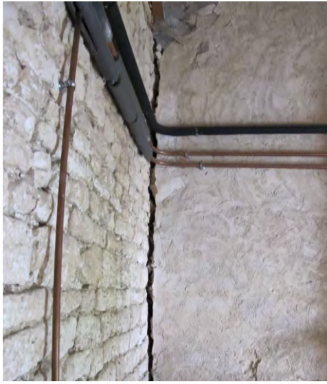
Fig. 38 – Vulnérabilité A, décollement du mur. Fig. 39 – Fissures sur mur intérieur.
