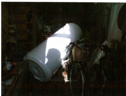
Fig. 28 – Chute d'un chauffe-eau électrique.
