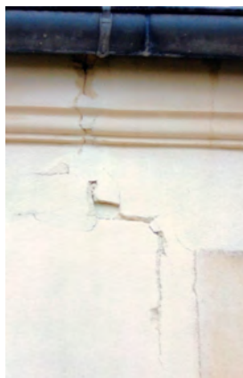
Fig. 25 – Fissures sur mur de façade (vulnérabilité A).
