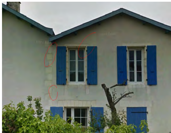
Fig. 10 – Endommagement visible en 2015 sur Angoulins (GoogleStreetView).
