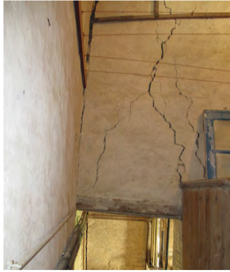
Fig. 38 – Vulnérabilité A, décollement du mur. Fig. 39 – Fissures sur mur intérieur.
