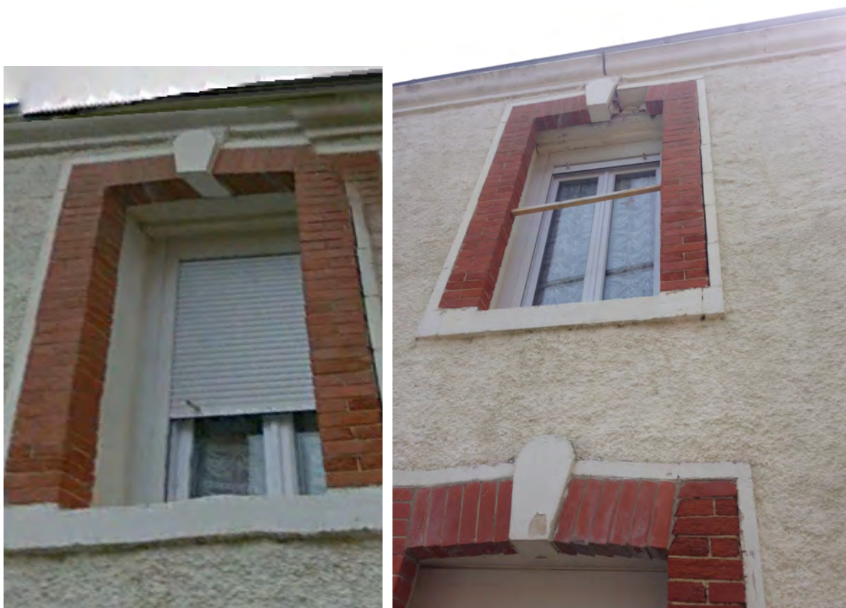
Fig. 14 - Chute de briques dans la partie supérieure de l'encadrement de la fenêtre – rue des dunes. (photo de gauche 2013, photo de droite 28 avril 2016).
