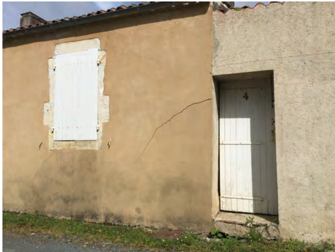
Fig. 40 – Fissuration légère en façade (rue de l'église).
