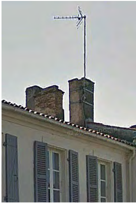
Fig. 41 – Etat de la cheminée (2013).
