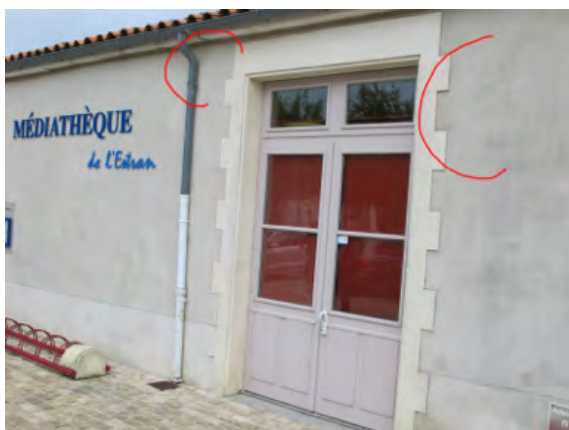
Fig. 24 – Fissures fines sur mur porteur (vulnérabilité A).
