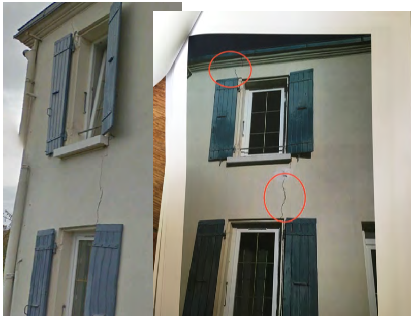
Fig. 43 – Fissuration déclarée suite au séisme (image de gauche Google 2013, image de droite après séisme).
