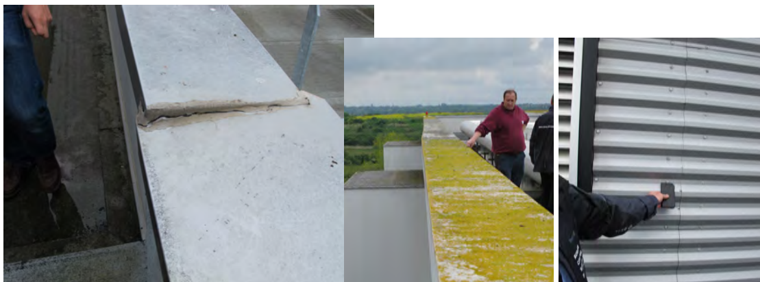
Fig. 44 – Endommagement du joint en silicone.
