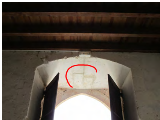
Fig.35 - Chute de la clef de voûte (ici réparée).
