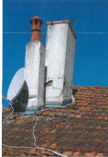
Fig. 31 – Fissuration et éclatement de crépis de cheminée.
